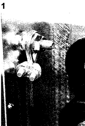
Bauseits Kabel-Ende Versiegeln
